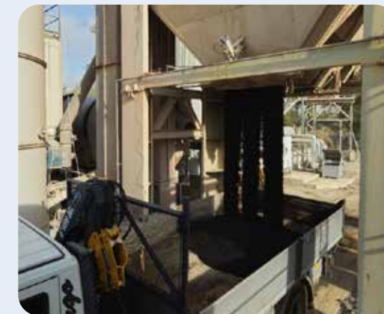
Conglomerato bituminoso (asfalto)
